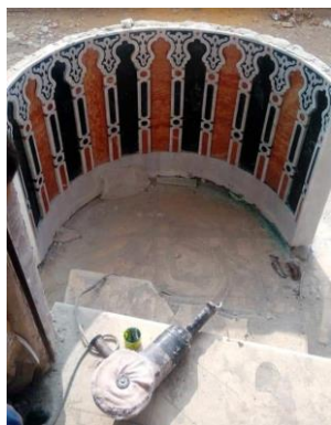
صورة(33): المرحلة النهائية من الجلي للجزء السفلي من البدن (الحزام السفلي والوزر)، وتوضح الصورة فرشاة التلميع النهائي.
